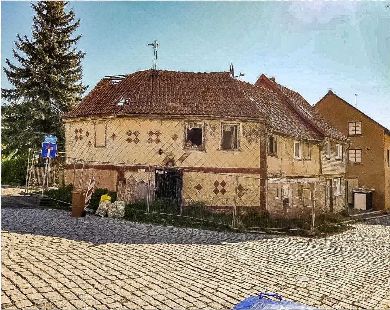
FOTO EHEMALIGER BESTAND - WEST-SEITE FACHWERKHAUS MIT BLECH-SCHINDEL-FASSADE
